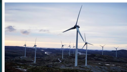
WINDKRAFT: Gjennom åra har byggingen av vindmøller, også kalla vindturbiner, generert mykje motstand frå både folkebevegelse og naturvernans. Samtidig er dei sett på som ein del av løysinga på klimastillinga. Bildeet er tatt på Ytre Vikna vindpark i Nærøysund i Trøndelag.
